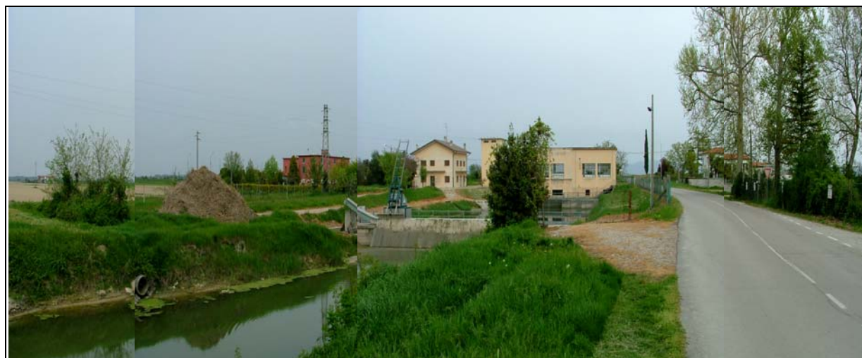
Vista verso il complesso Idrovaro dalla viabilità che collega l'abitato di Fossalon (Punto 2)
