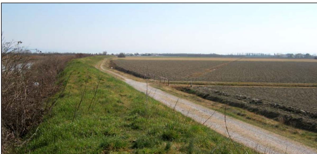
Quadro paesaggistico in cui si ubica l'intervento di riprofilatura della banchina
